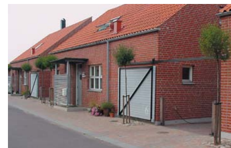
Östvästliga gator: En stadig kant av bebyggelse längs gatans södra sida.
