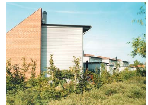
En våning och en brant taklutning mot gatan, två våningar och ett flackt tak mot trädgården.
