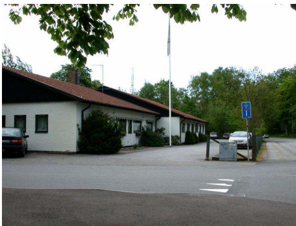
Vy från korsningen Plantskolevägen/S. Västkustvägen mot söder
