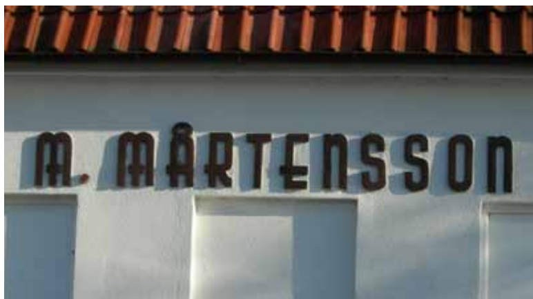
Skyltning med friliggande bokstäver direkt på fasad
