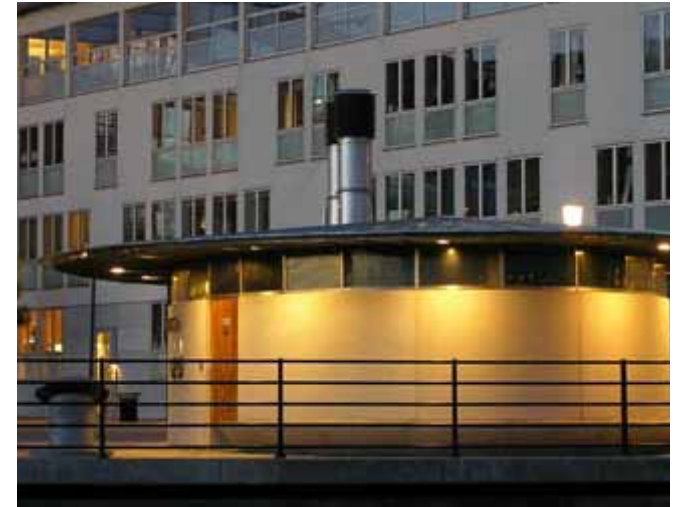
Hamnkontor (Västra hamnen Malmö)
