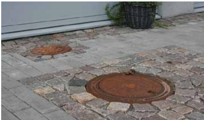
Gatsten längs hus och runt brunnar och liknande
