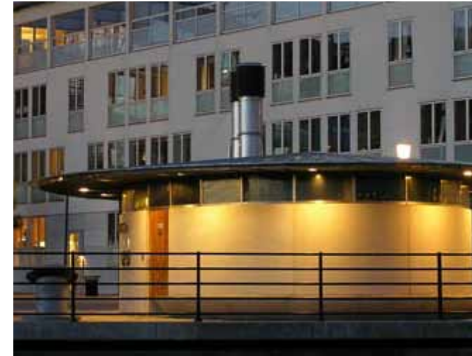
Hamnkontor (Västra hamnen Malmö)
