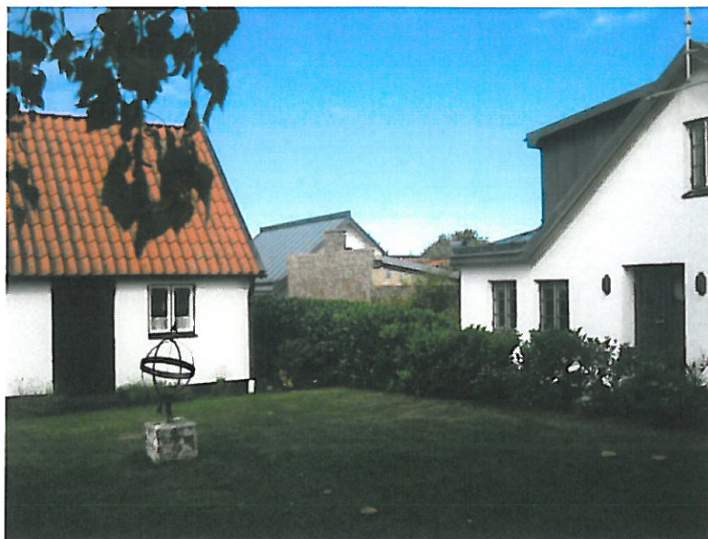
Huvudbyggnad på Karstorp 23:20 till vänster och bostadshus på Karstorp 23:18 till höger. I mitten av bilden syns den östra bostadsbyggnaden på Karstorp 23:18 med grått plåttak.
