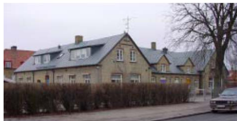
Den östra skolbyggnaden.
